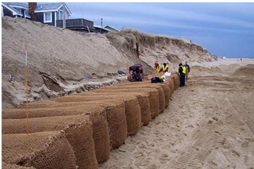
Figura 8 - Esempio di geocontenitori posizionati al piede della duna ricostruita (Progetto Netco), in questo caso senza protezione della palificata
