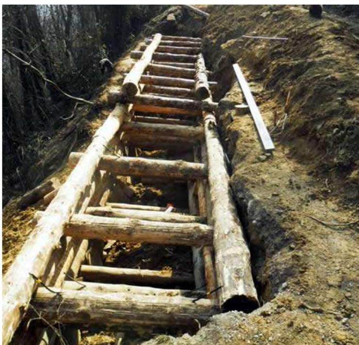
**Figura 5 - Esempio di struttura della palificata doppia**
