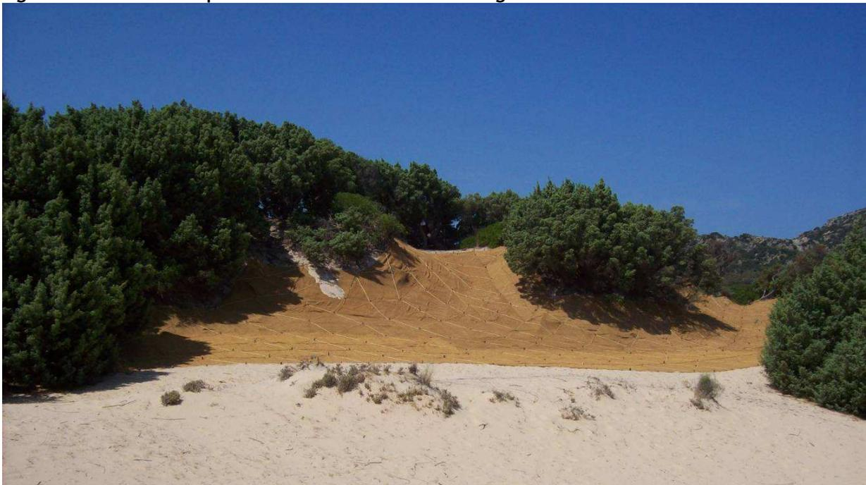
**Figura 10 - Georeti poste in opera a protezione della superficie della duna**
